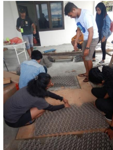
Gambar 1. Perangkaian BESE-Element
