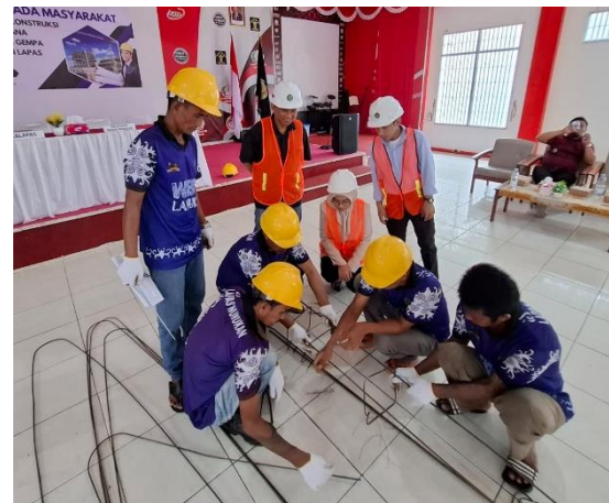
Gambar 4. Warga binaan melakukan praktek pemasangan tulangan balok dan kolom
