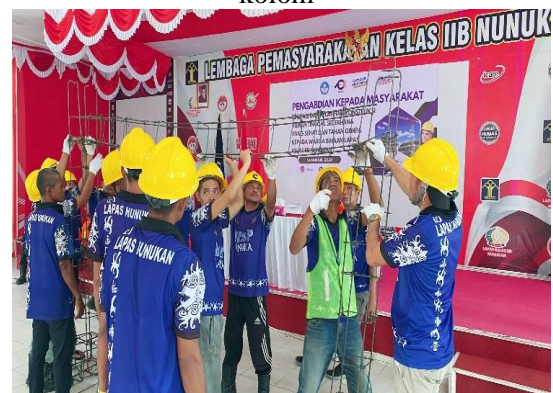
Gambar 4. Warga binaan melakukan praktek pemasangan tulangan balok dan kolom
